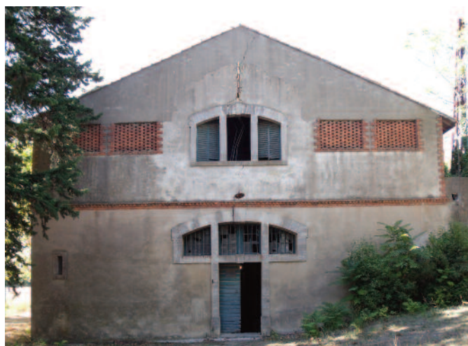
Mur pignon est du chai construit après la suppression de la croupe. La fenêtre haute correspond à la lucarne de la croupe.
