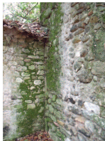
Mur de la chapelle nord (à gauche), appuyé contre le mur gouttereau de la nef (à droite).
