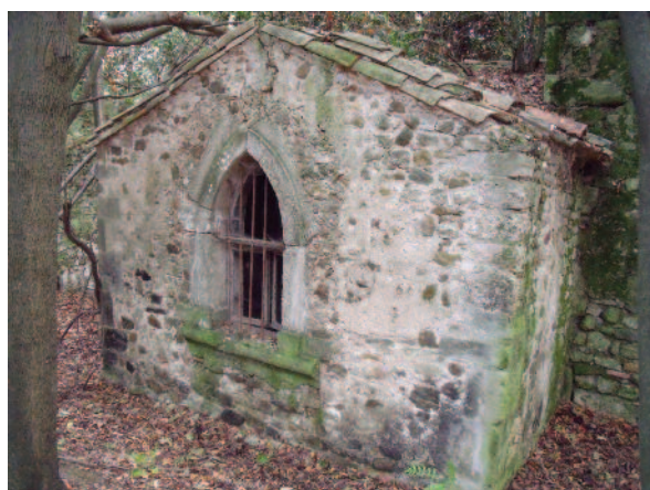
Au-dessus, mur nord de la chapelle nord. Fenêtre néogothique insérée en sous-œuvre.
